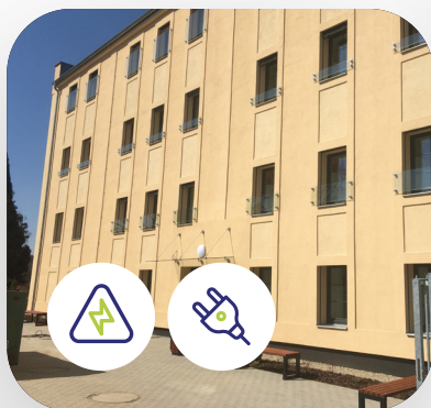
Konverze bývalého mlýna na budovu ZŠ
